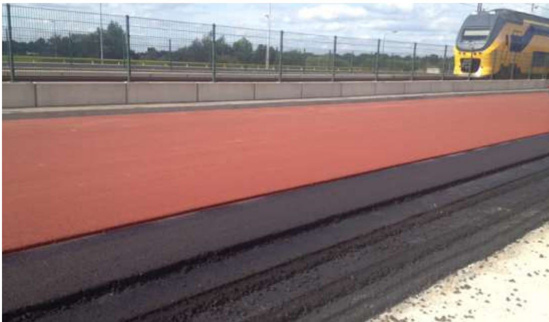
Rysunek 22. Nawierzchnia nowej trasy rowerowej z 5 warstw asfaltu na nowym wiadukcie przez autostradę A2.
