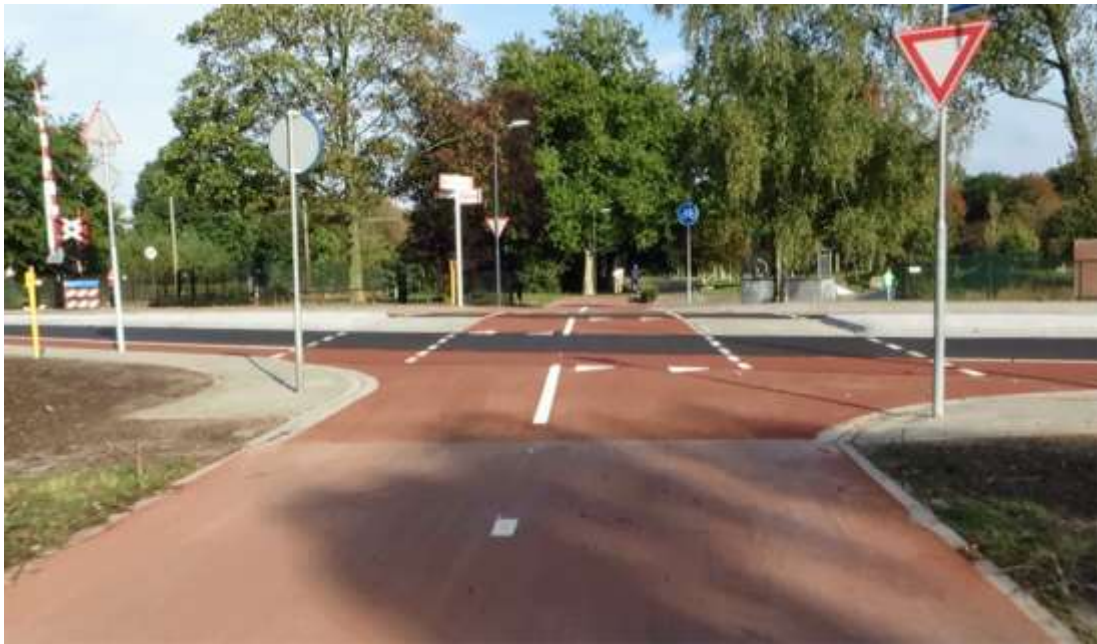
Rysunek 23. Skrzyżowanie drogi dla ruchu samochodowego w Rosmalen bez uprzywilejowania dla rowerów
